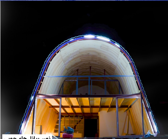
نصب پانل های چوبی
